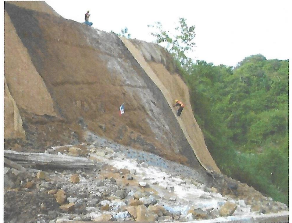
Proyecto de control de erosión en Taludes de accesos al puente Centenario en el Canal de Panamá
